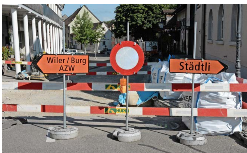
Achtung, Baustelle: Im Eglisauer Städtli werden gerade die ersten Massnahmen im Rahmen des Betriebs- und Gestaltungskonzepts umgesetzt.
